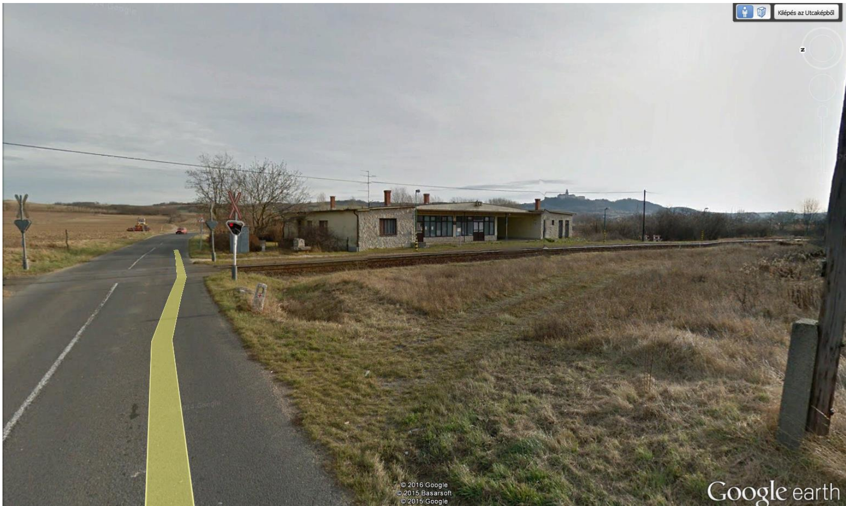
Écs megállóhelytől a pálya jobb oldalán földút a kerethíd felé
