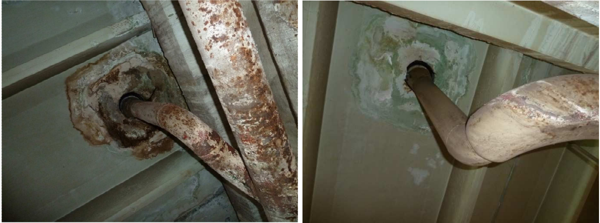
AZ ÖSSZEFOLYÓK KÖRNYEZETE ÉS A KORRODÁLÓDOTT CSAPADÉKVÍZELEVEZETŐ RENDSZER
