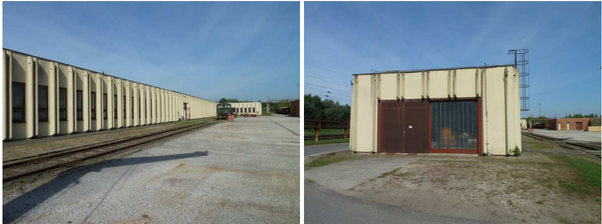
A SZOCIÁLIS ÉPÜLET UDVAR FELŐLI ÉS VÉGHOMLOKZATA
