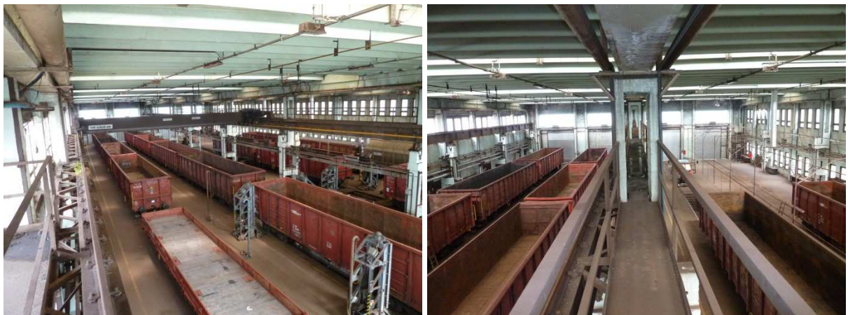
A KOCSIJAVÍTÓ CSARNOK BELSŐ KÉPEI
