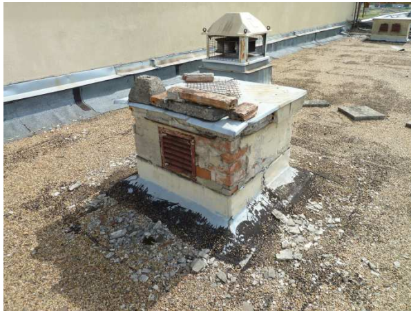
A SEGÉDMŰHELYSOR FELETTI TETŐ ÉS A FELÉPÍTMÉNYEI
