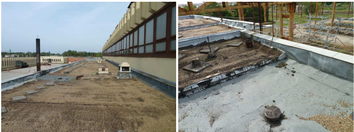
AZ ÖSSZEFOLYÓK KÖRNYEZETE ÉS A KORRODÁLÓDOTT CSAPADÉKVÍZELEVEZETŐ RENDSZER
