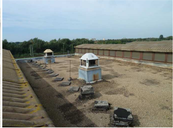
A KOCSIJAVÍTÓ CSARNOK LAPOSTETŐ KIALAKÍTÁSA
