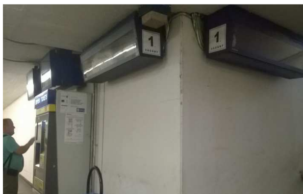
Vágányok nem megfelelően érzékelhető jelölése.
