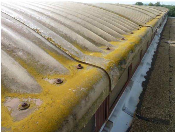
A KOCSIJAVÍTÓ CSARNOK FELÜLVILÁGÍTÓKIALAKÍTÁSA
