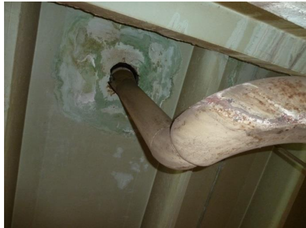
AZ ÖSSZEFOLYÓK KÖRNYEZETE ÉS A KORRODÁLÓDOTT CSAPADÉKVÍZELEVEZETŐ RENDSZER
