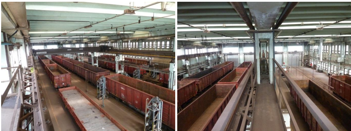
A KOCSIJAVÍTÓ CSARNOK BELSŐ KÉPEI
