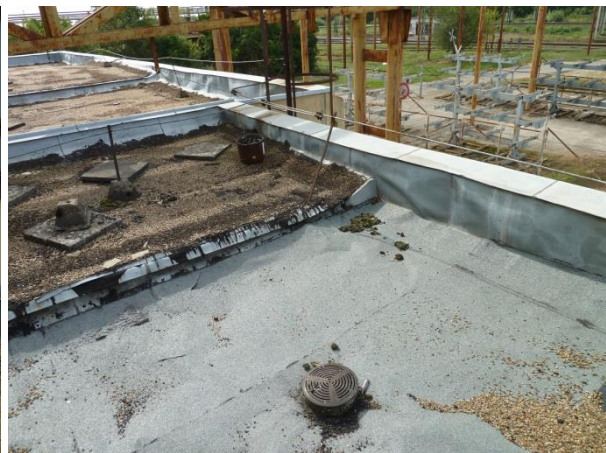
AZ ÖSSZEFOLYÓK KÖRNYEZETE ÉS A KORRODÁLÓDOTT CSAPADÉKVÍZELEVEZETŐ RENDSZER
