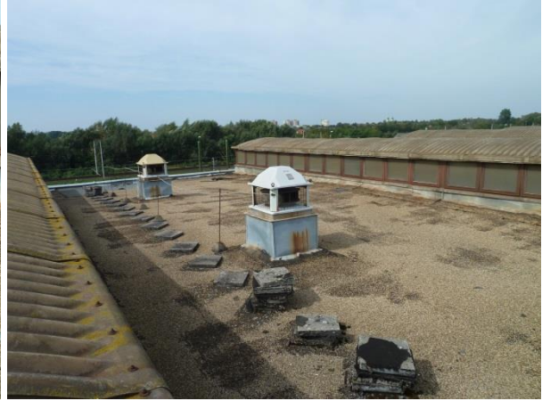
A KOCSIJAVÍTÓ CSARNOK LAPOSTETŐ KIALAKÍTÁSA
