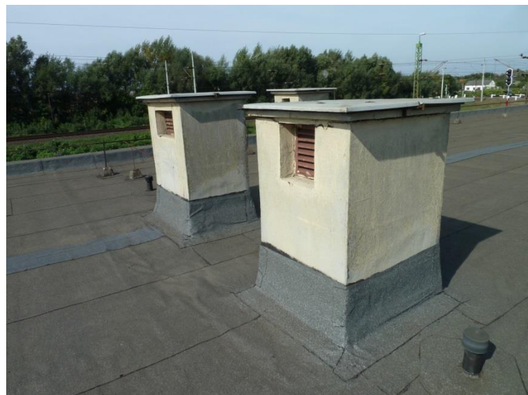
A LAPOSTETŐ, A KORÁBBI JAVÍTÁSOK ÉS A SZIGETELÉS FELVEZETÉSÉNEK KIALAKÍTÁSA
