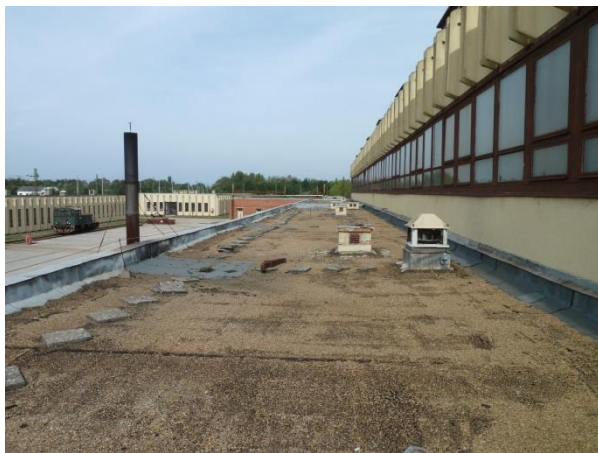
AZ ÖSSZEFOLYÓK KÖRNYEZETE ÉS A KORRODÁLÓDOTT CSAPADÉKVÍZELEVEZETŐ RENDSZER
