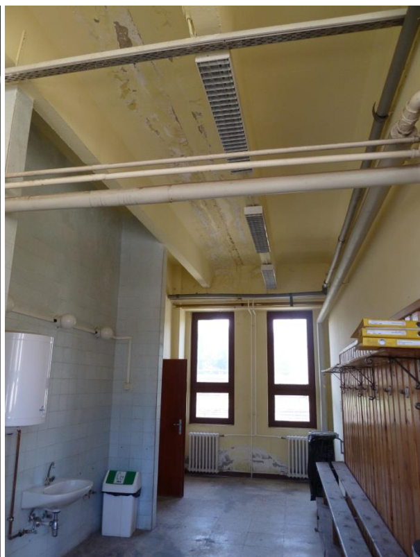
A SZOCIÁLIS ÉPÜLET ÖSSZEFOLYÓINAK KÖRNYEZETE ÉS A BEÁZÁSOK OKOZTA KÁROSODÁSOK
