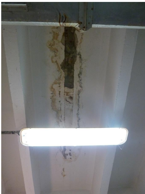
A SZOCIÁLIS ÉPÜLET ÖSSZEFOLYÓINAK KÖRNYEZETE ÉS A BEÁZÁSOK OKOZTA KÁROSODÁSOK
