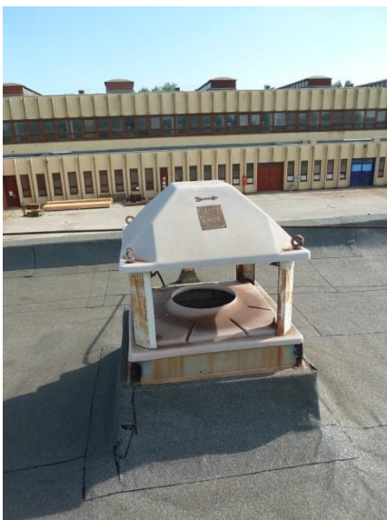
A LAPOSTETŐ, A KORÁBBI JAVÍTÁSOK ÉS A SZIGETELÉS FELVEZETÉSÉNEK KIALAKÍTÁSA
