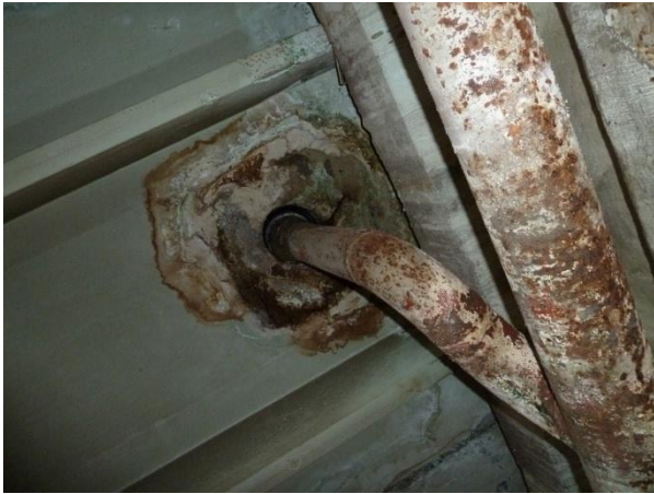
AZ ÖSSZEFOLYÓK KÖRNYEZETE ÉS A KORRODÁLÓDOTT CSAPADÉKVÍZELEVEZETŐ RENDSZER
