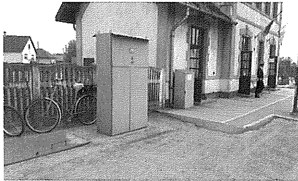
5. ábra Nyíradonyi MÁV Zrt. állomás energiaellátó elosztószekrény
